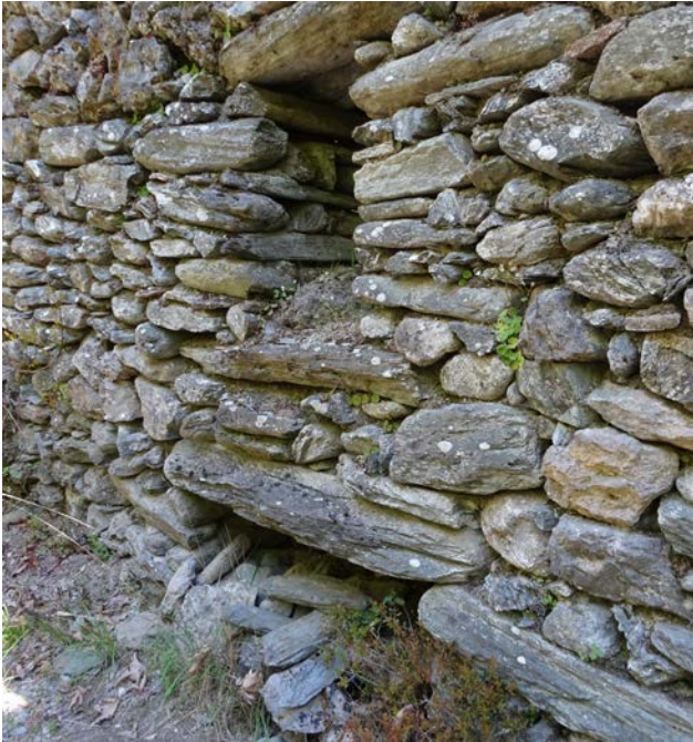
Εικ.5. Οι έξοδοι του ζωριού (χούρχουρης) στην τοιχοποιία της πρόσοψης δύο νερόμυλων του ρέματος (φωτ. Όλγας Λεκού & Στέφανου Νομικού).
