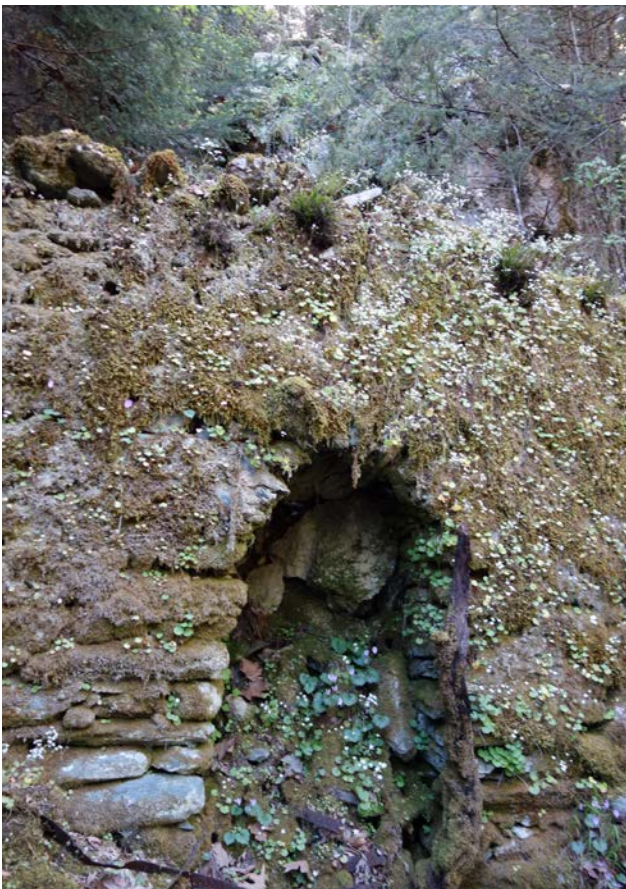
Εικ.7. Τα ανοίγματα στο εσωτερικό του πίσω τοίχου για την είσοδο του βαγενιού προς τη φτερωτή σε δύο νερόμυλους του ρέματος. Στη δεύτερη εικόνα διακρίνεται και ο τοξωτός τρόπος κατασκευής της οροφής του ζωριού (φωτ. Όλγας Λεκού & Στέφανου Νομικού).
