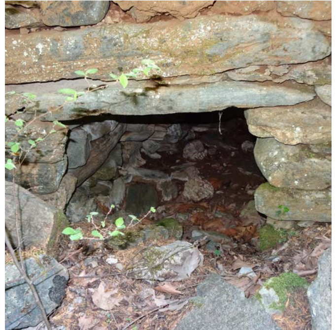
Εικ.5. Οι έξοδοι του ζωριού (χούρχουρης) στην τοιχοποιία της πρόσοψης δύο νερόμυλων του ρέματος (φωτ. Όλγας Λεκού & Στέφανου Νομικού).
