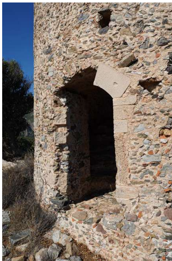
Εικ. 7 Το περιθύρωμα της εξώθυρας του πάνω μύλου από το οποίο έχουν αφαιρεθεί γωνιόλιθοι.
