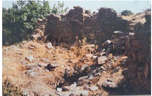
Εσωτερικό του αριστερού τοίχου με τζάκι. Δεξιά η βάση για το καρούτι και μπροστά ο θόλος για τη φτερωτή
