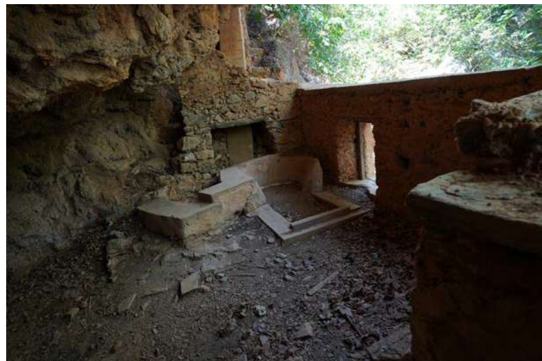
Εικ. 19 Ότι απομένει στο εσωτερικό του νερόμυλου στα Λιρά.
