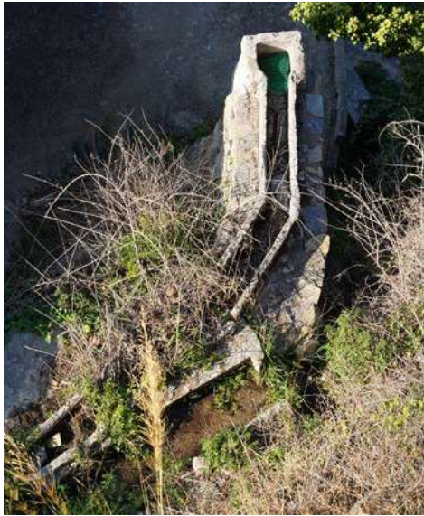
Εικ. 16 Μετά την έξοδο του νερού από ένα ζωριό, νεραύλακο το οδηγούσε κατευθείαν στο βαγένι του επόμενου.
