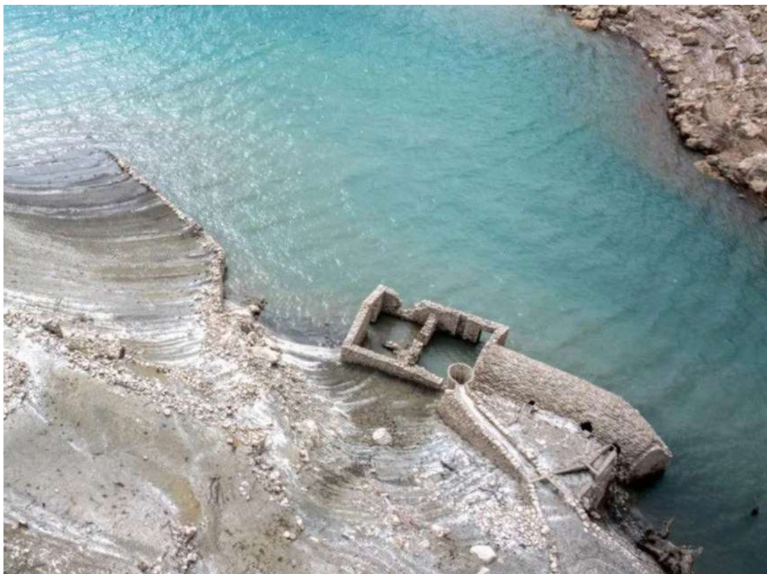
Φωτ.3. Κάτοψη του συγκροτήματος του δεύτερου νερόμυλου. Διακρίνεται το μυλαύλακο και η στρογγυλή κρέμασή του, επίσης μεταλλική η τοιμέντινη. Όπως επίσης και το μυλόσπιτο.
