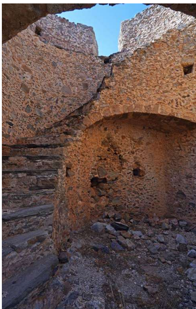
Εικ. 6 Η κλίμακα ανόδου στο ανώι του πάνω μύλου εδρασμένη σε ένα μεγάλο τόξο.
