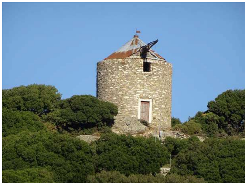
Φωτ.1 Ο ανεμόμυλος του γερο-Λαφαζάνη, με αποκατεστήμενη πια τη λιθοδομή του πύργου (φωτ. Στεφ. Νομικός, 2015)
