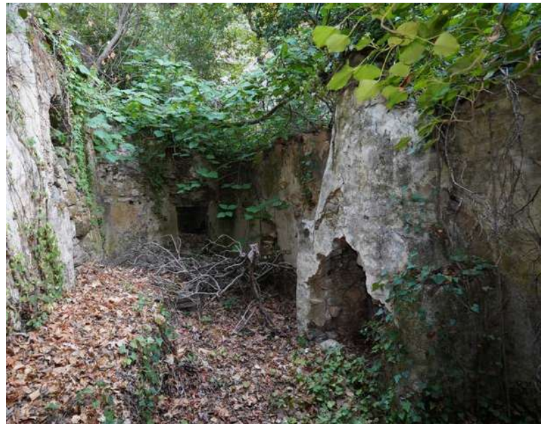
Εικ. 24 Το ερειπωμένο εσωτερικό του 4ου νερόμυλου στα Τάλαντα, καλυμμένο από βλάστηση.
