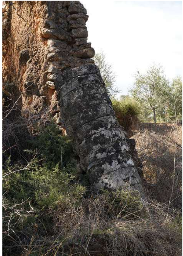
Εικ. 30 Το βαγένι από πέτρινους δακτυλιόλιθους στον ερειπωμένο πάνω νερόμυλο στις Βελιές.
