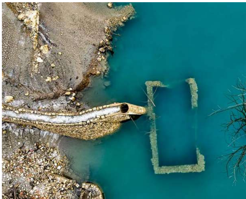
Φωτ. 1. Κάτοψη. Νερόμυλος πλατυμέτωπος και μυλαύλακο κτιστό με τη στρογγυλή κρέμασή του, πιθανόν μεταλλική ή και τσιμέντινη.
