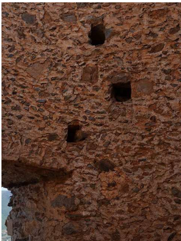
Εικ. 8 Λεπτομέρεια του επιχρίσματος της τοιχοποιίας του πάνω μύλου.
