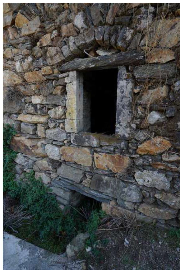
Εικ. 15 Η πρόσοψη ενός από τους μικρούς σκαλωτούς νερόμυλους στο Παραδείσι. Κάτω από το παράθυρο διακρίνεται η έξοδος του νερού από το ζωριό.
