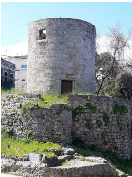
Εικ. 8 Ανεμόμυλος στην οδό Ερυθρού Σταυρού 24.
