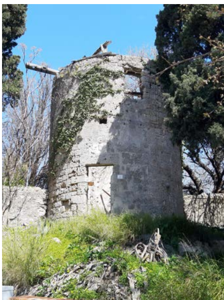
Εικ. 9 Ανεμόμυλος στην οδό Ερυθρού Σταυρού 11
