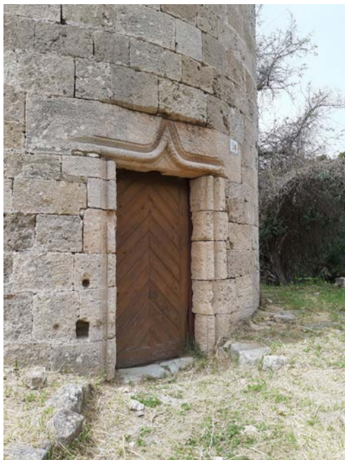
Εικ. 31 Ανεμόμυλος στην οδό Ερυθρού Σταυρού 24, λεπτομέρεια
