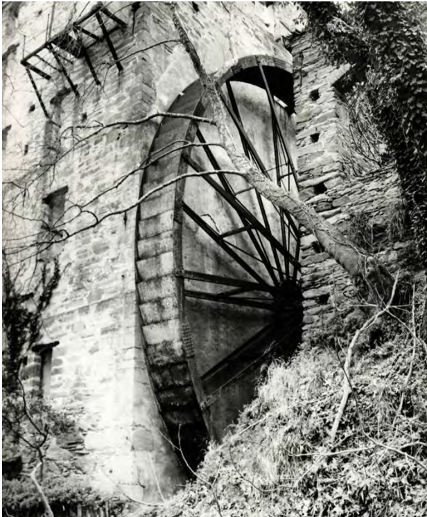
4. Η κάθετη σιδηρά φτερωτή της Φάμπρικας, διαμέτρου 13 μ., από τις μεγαλύτερες σωζόμενες στην Ευρώπη / The vertical water wheel, 13m in diameter, one of the largest surviving in Europe
